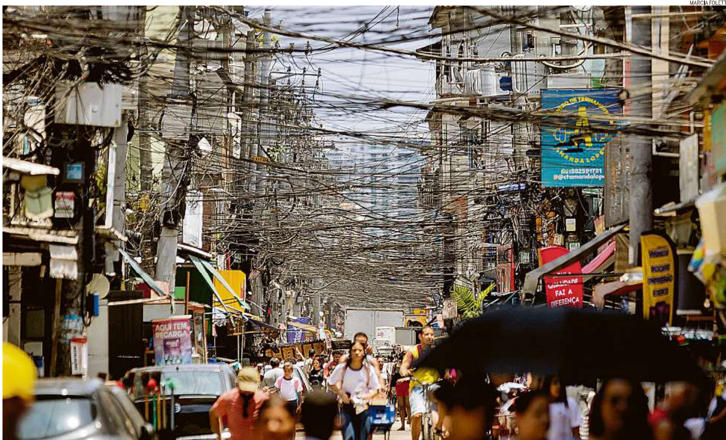
Céu riscado por fios. O emaranhado de cabos sobre os pedestres na Avenida Areinha, na comunidade de Rio das Pedras, na Zona Oeste do Rio, dá dimensão à expansão desordenada da distribuição de energia
